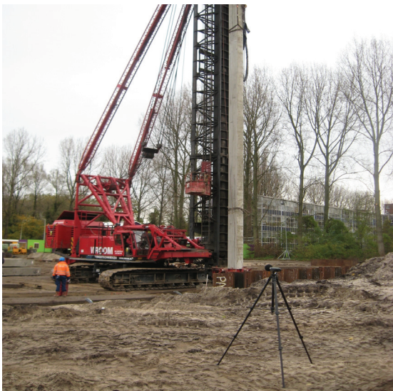
Bouwlawaai: geluidmonitoring van heikwerkzaamheden
