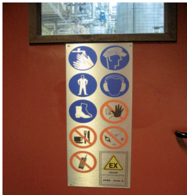
Waarschuwbord op toegangsdeur van productieruimte. De ruimte is ATEX-gezoneerd vanwege opslag en mengen van alcoholproducten.
