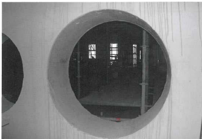
In de betonnen constructie zijn grote sporingen aangebracht voor de ventilatie.
