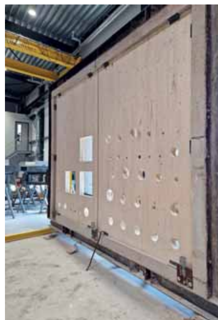
CLT-wand in voorbereiding.
