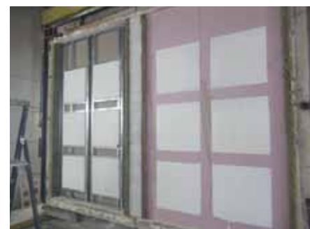
Schachtwand in voorbereiding (Preficon).
