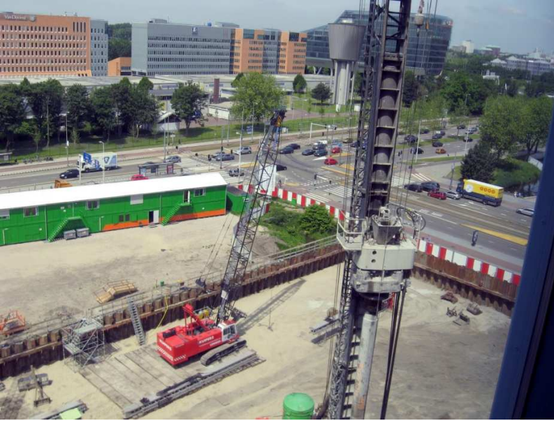
Figuur B - Fundatiewerkzaamheden
