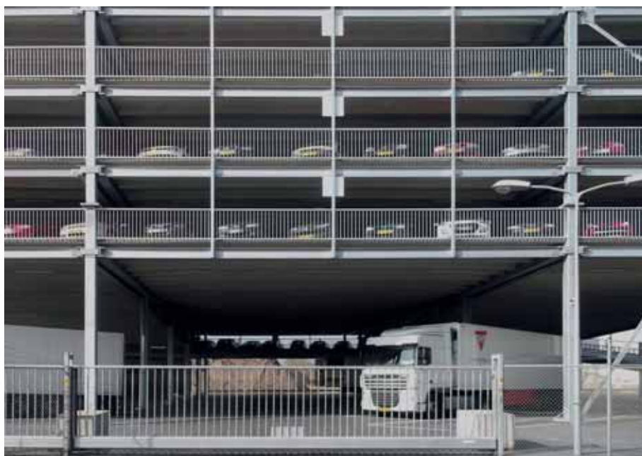
Figuur 1. Parkeren in de buitenlucht of in een brandcompartiment?
