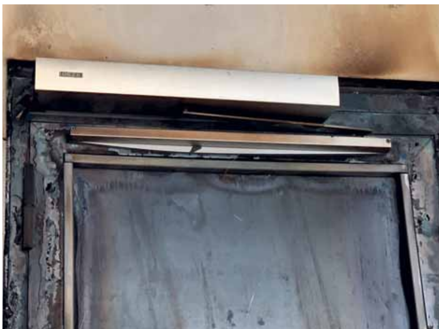
Beproeving van een gestuurde dranger van Geze Benelux op een ongeïsoleerde stalen deur (foto: Peutz).
