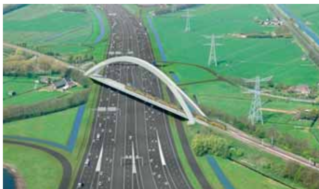
FIGUUR 2: NIEUWE SPOORBRUG OVER DE A2 BIJ MUIDERBERG
