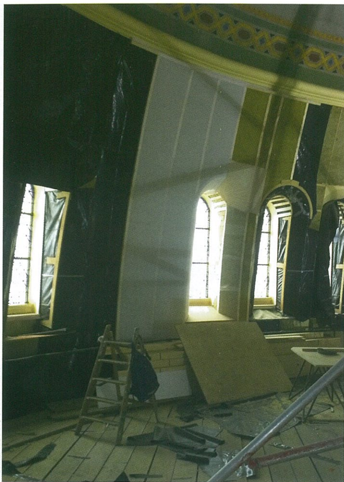
De zaal is voorzien van 650 m 2 aan breedbandige geluidsabsorptie met een zeer hoge en vlakke geluidsabsorptie-curve.
