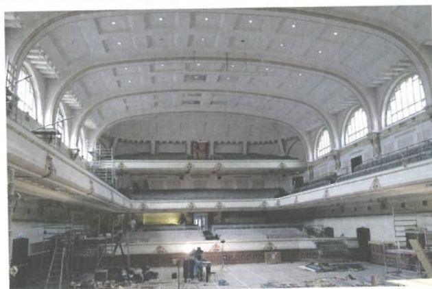
De concertzaal tijdens de renovatiewerkzaamheden.
