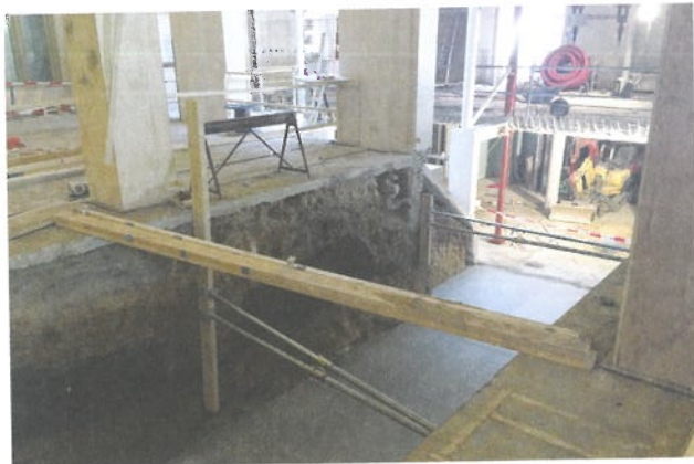
Bij het aanleggen van de ondergrondse bypass is eerst de grond verstevigd met een injectiemiddel. Zo is voorkomen dat de bestaande fundering wegzakte.
