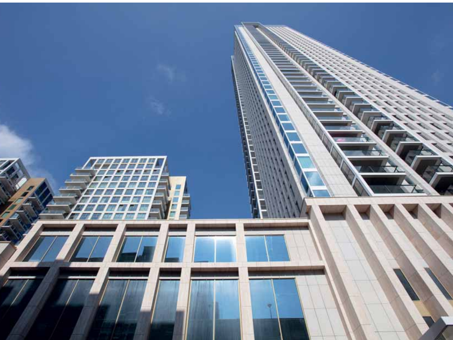
De Zalmhaventoren Rotterdam: ontruimingsconcept C
