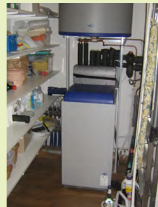
-Foto 3- Warmtepomp van het appartement
