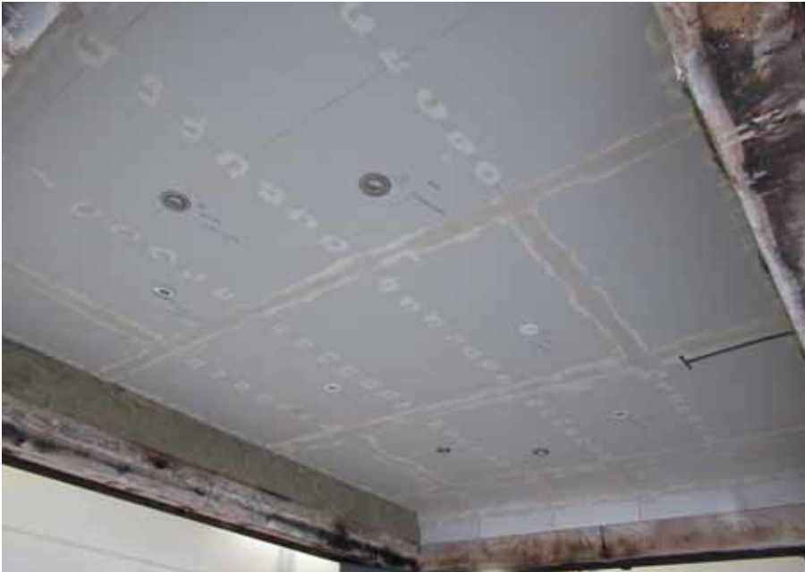
Afbeelding 1. Voorafgaand aan de test – verhitte (onder-)zijde van de vloer met duidelijk zichtbaar de brandwerende inbouwspots.
