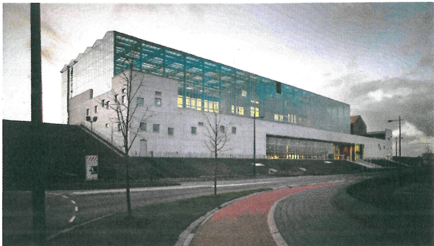
Door de omhulling van de serre zijn de huisjes in feite voorzien van een extra thermische schil.
