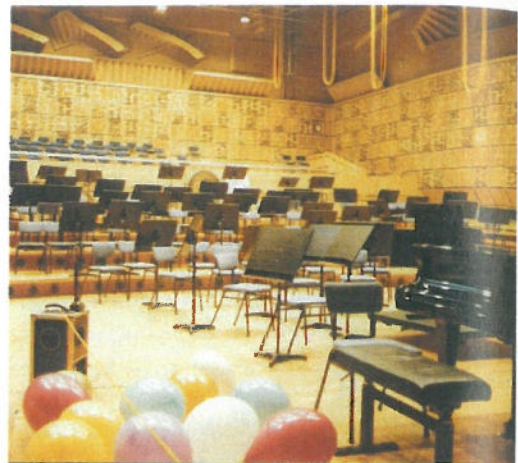
UNGEWÖHNLICH: Gemeinsam mit Architekten gestaltete Treppendiffusoren sorgen im Studio MCO5 des niederländischen Rundfunks für genügend Diffusität.
