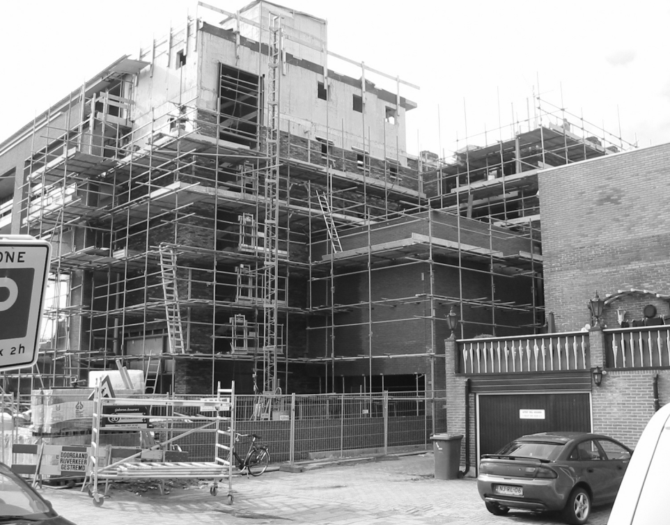
In een situatie vergelijkbaar met de situatie op de foto dienen geluidemissies nabij woningen voorafgaand aan de bouw te worden berekend om mogelijke overschrijdingen van geluidgrenswaarden tijdig te signaleren en daarop te anticiperen.
