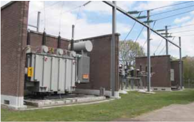
FIGUUR 3: EEN TYPISCHE TRANSFORMATOROPSTELLING MET IN- EN UITGAANDE LIJNEN
