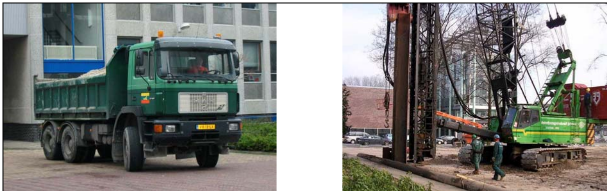
Figuur 4 Bouwnijverheid in de omgeving van een laboratorium kan gepaard gaan met intensief vrachtverkeer en hei- of trilwerkzaamheden.
