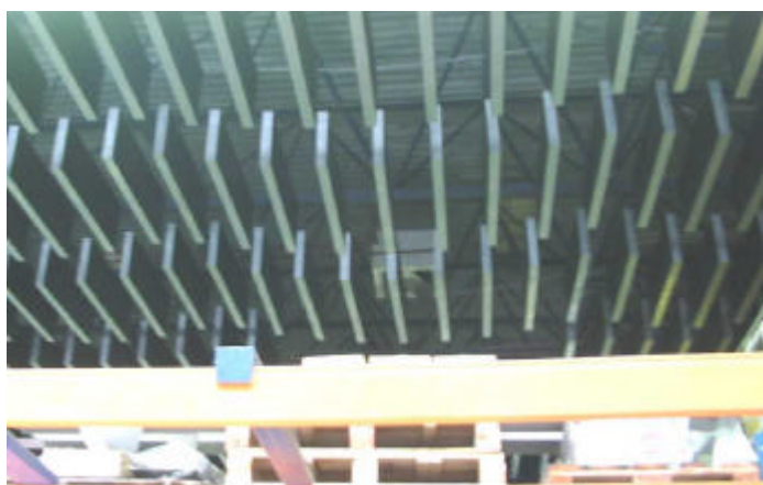
Figuur 2 Mogelijke uitvoering geluidabsorptie in de vorm van baffles
